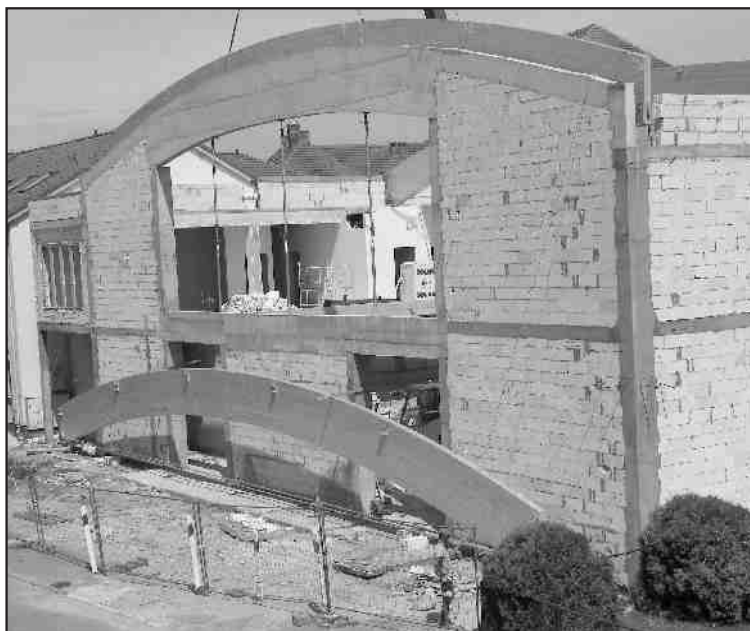
Hala w budowie...
